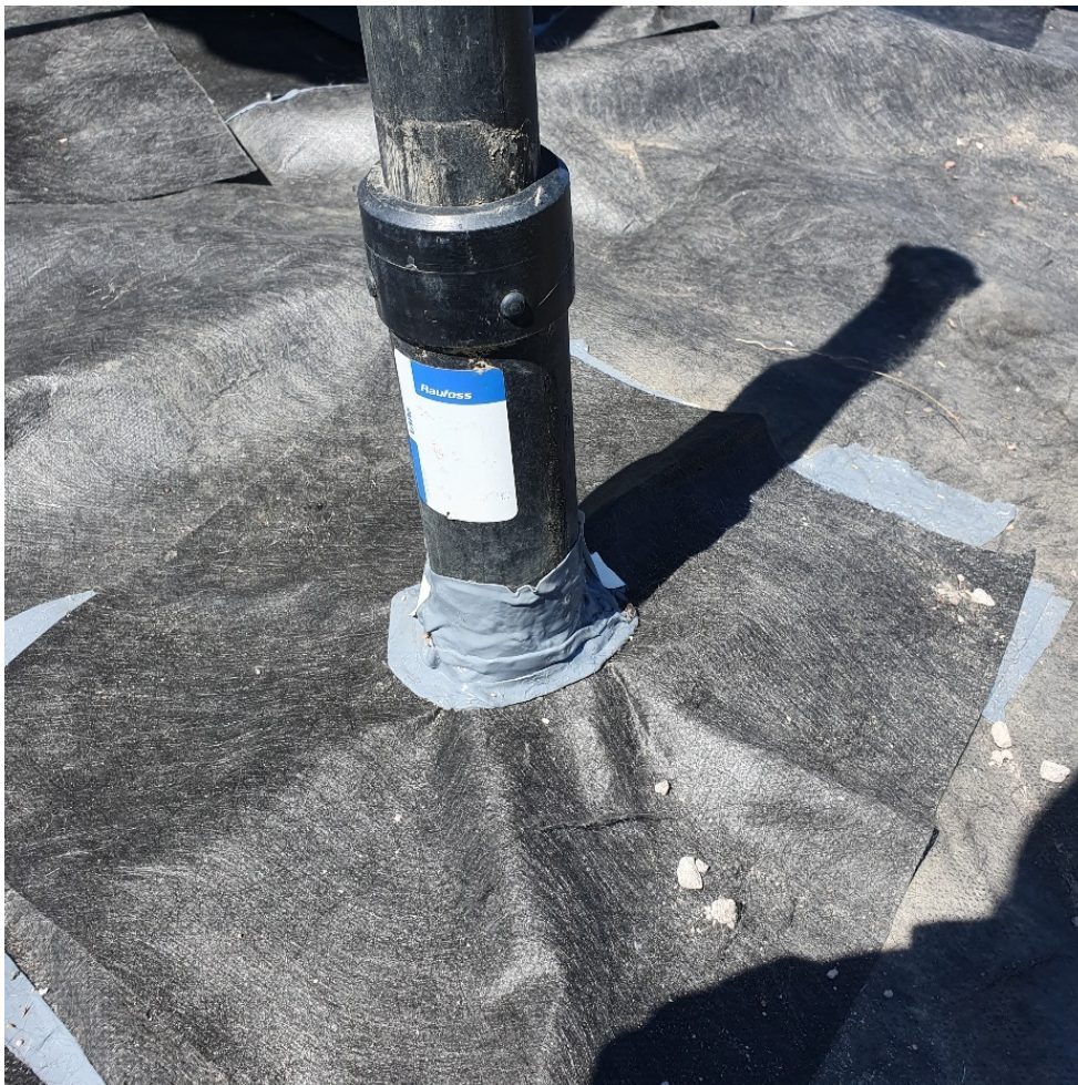
Figur 19 Tätning mot befintliga objekt.
