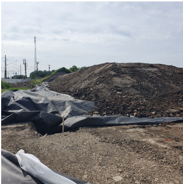
Figur 16 Upplag av icke kontaminerade schaktmassor.
